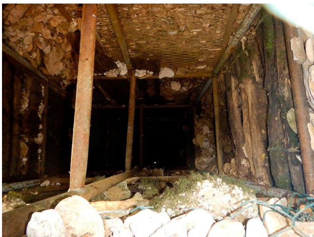
Imposant travail d'étayage effectué par le CLRS dans les années 90
