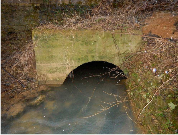
Entrée de la galerie artificielle menant à la résurgence de Rachecourt en hautes eaux
