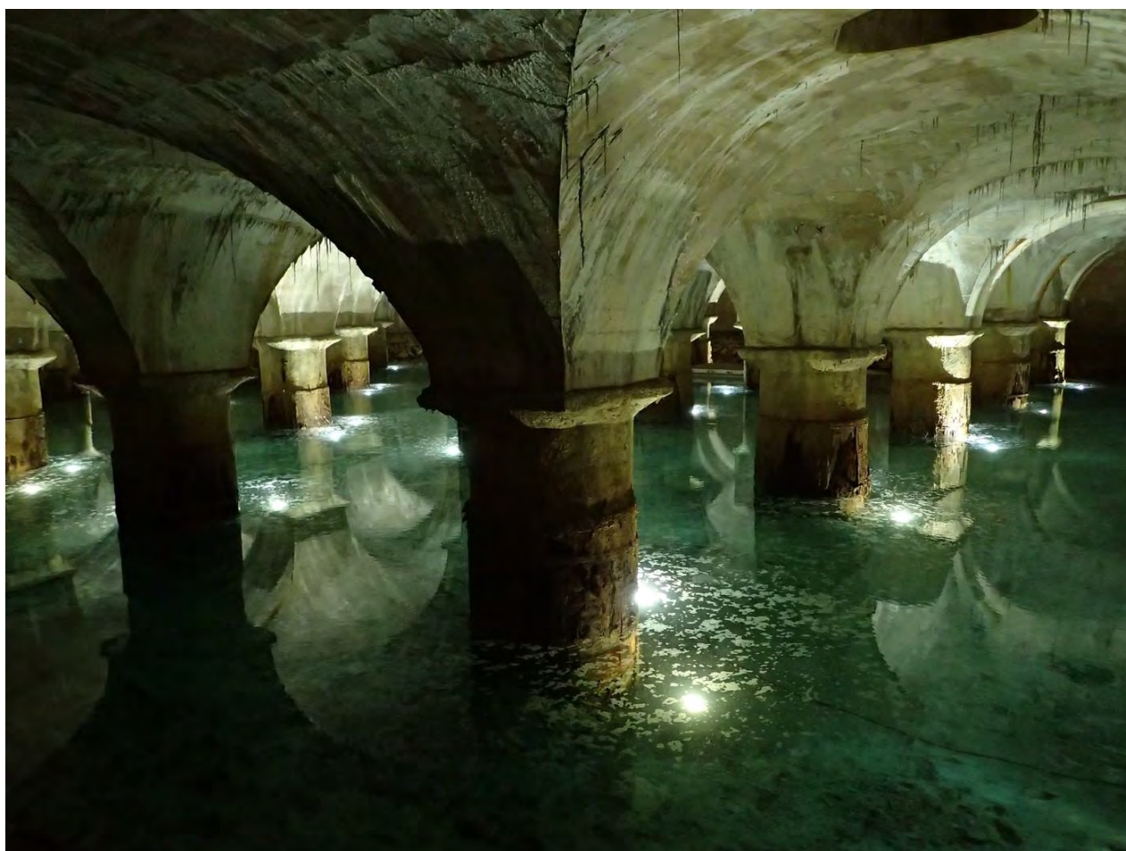
Bassin filtrant de Saint Clair
