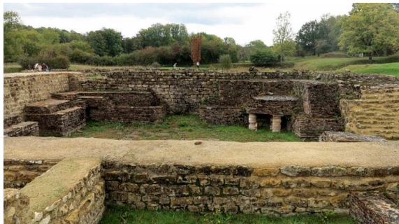
Chauffage par le sol des bains.
