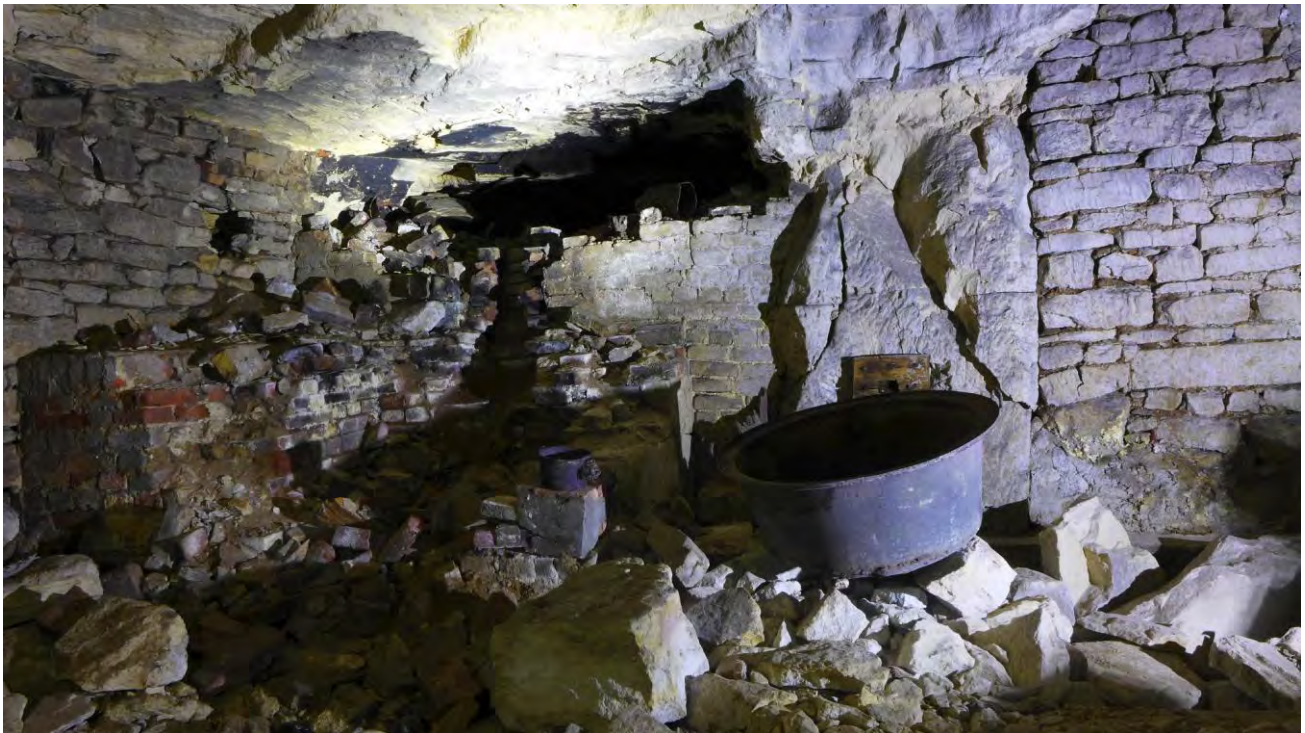
Cantonnement de la creute de Cour Soupir, état actuel
