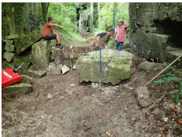
Préparation du site : on bouge les blocs...
