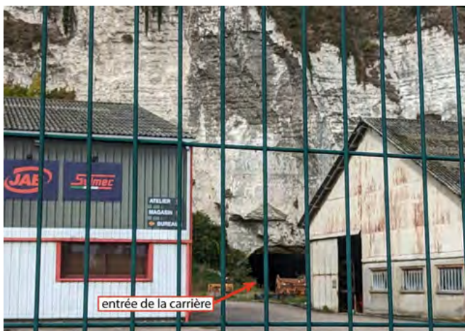
La carrière d'accès au bas du puits
