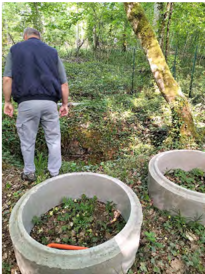
Buses près de l'entrée, en attente de pose
