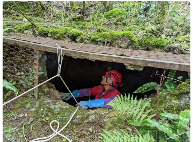
Les broches sont au plafond (cliché S. Sauret)
