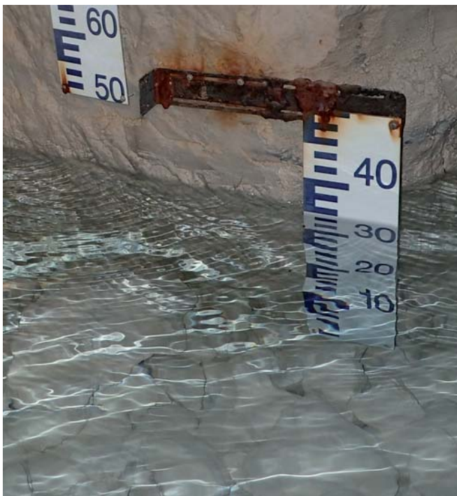
Mesure du niveau de l'eau à Saint-Martin-le-Noëud
