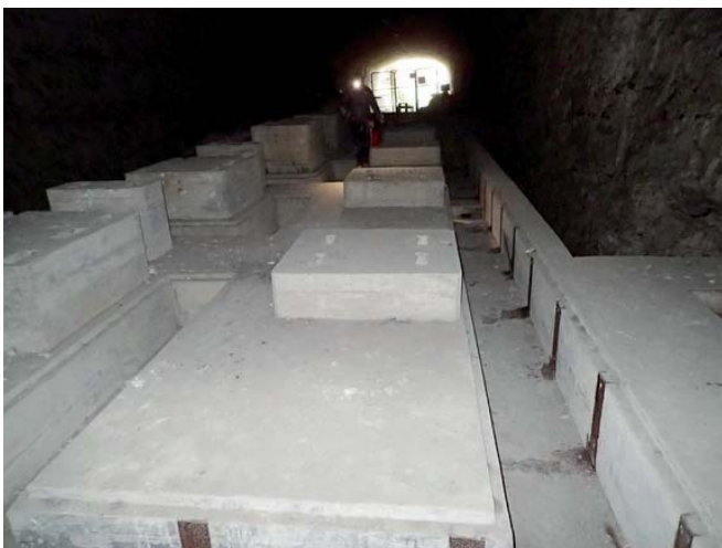
Les blocs de béton attendant les compresseurs
