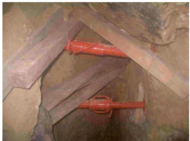
Étayage de la tête de puits
