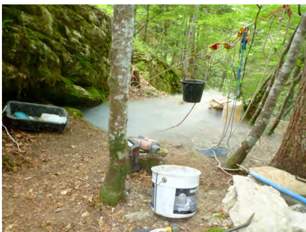
Trou Carré, sortie des gaz de tir
